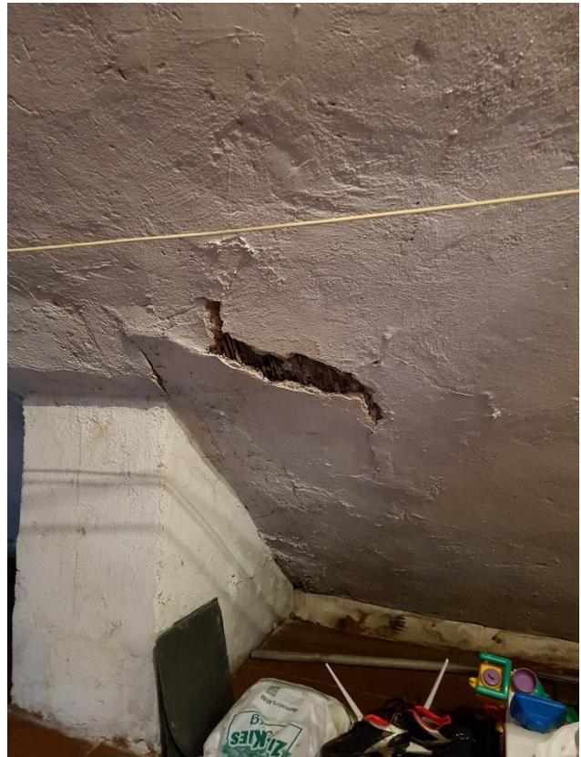
Objekt Weststr. 22 vor Teilerneuerung Heizungsanlage / Therme und Wasserkessel sowie Dachsanierung / Geschossdeckendämmung letzte Geschossdecke inkl. defekter Innenverkleidung vor Sanierung
