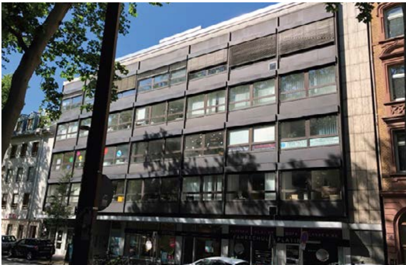
Abbildung 1: Vorderseite der Rheinstraße 43-45 in Mainz (vor der Fassadensanierung). Das Gebäude befindet sich in gefragter Innenstadtlage und verfügt über eine sehr gute Anbindung an den öffentlichen Nahverkehr.
