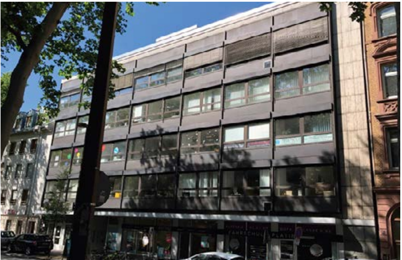
Abbildung 1: Vorderseite der Rheinstraße 43-45 in Mainz (vor der Fassadensanierung). Das Gebäude befindet sich in gefragter Innenstadtlage und verfügt über eine sehr gute Anbindung an den öffentlichen Nahverkehr.
